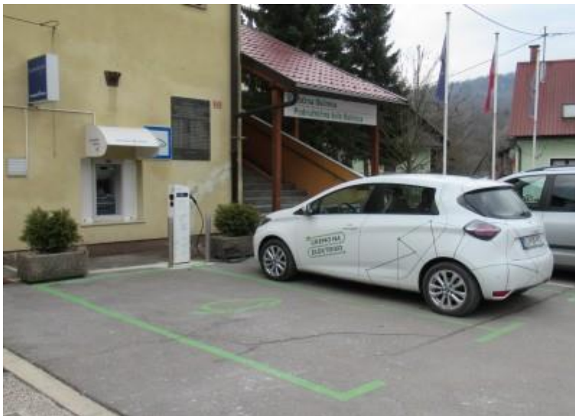
Slika 3.12: Električna polnilnica v občini Osilnica (VIR: https://polnilnice.gremonaelektriko.si/ )
